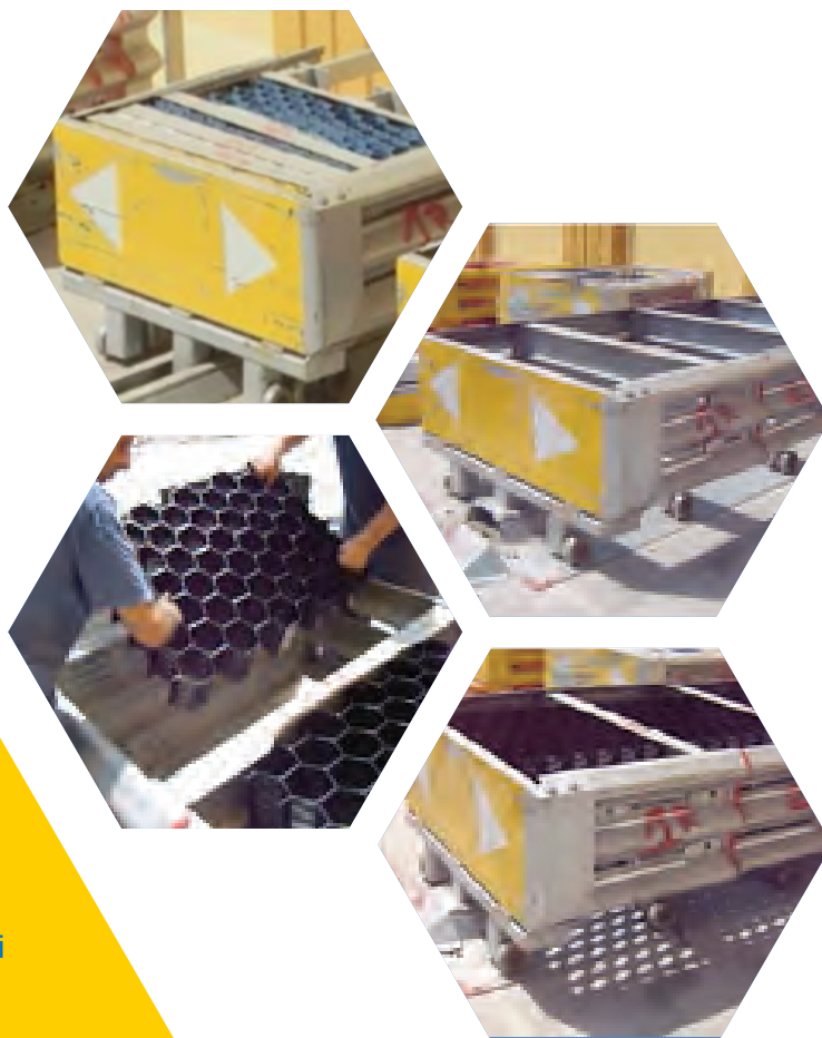
Ripristino attenuatori d'urto SMA 80 dopo crash test.
